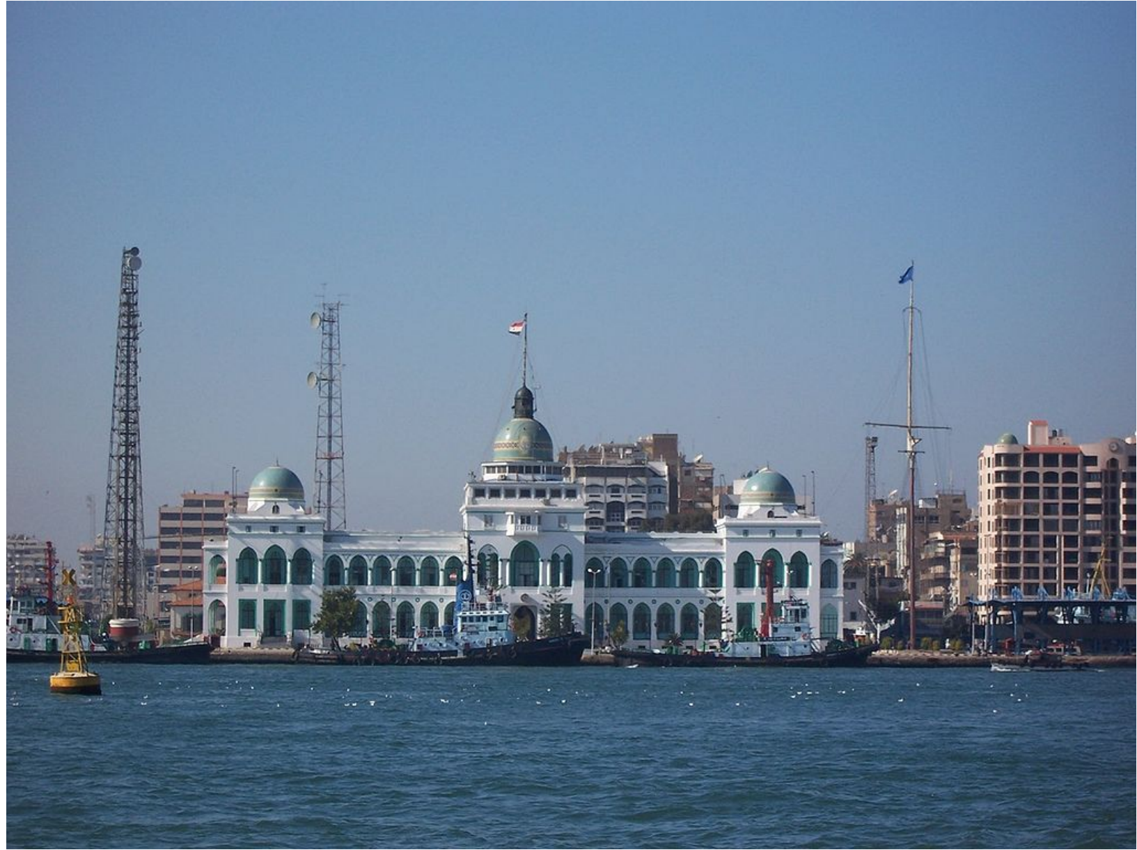
مبنى هيئة قناة السويس
